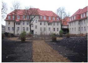
Haus 4 nach der Sanierung
